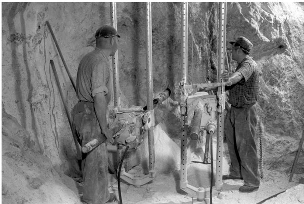
VEB Kaliwerk »Karl Liebknecht«, Bleicherode, Bohren der Schießlöcher 1955 (BArch, Bild 183-40244-001, Foto: Wittig)
